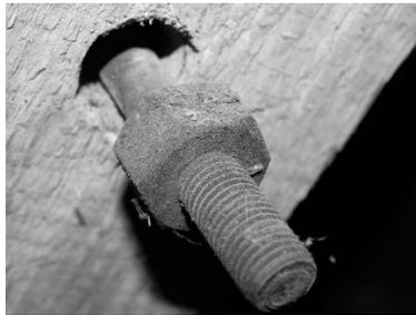
Рис.1 Болтовое соединение составной деревянной балки стропильной конструкции после 60 лет эксплуатации
