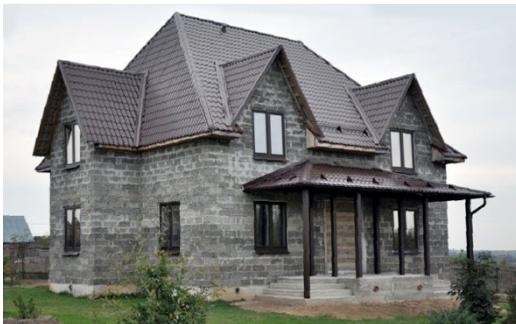
Рис. 2 Дом из арболитовых блоков
