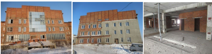
Рис. 1. Фасады здания и общий вид первого этажа
