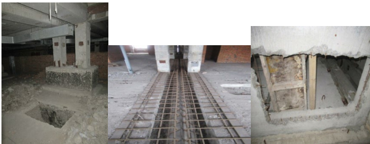
Рис. 2. Фото шурфа в подвале здания и участков незавершенного строительства
